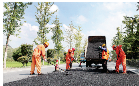
农村公路大中修
