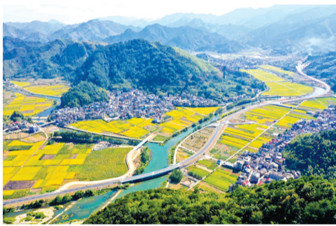
城底线村头至底本段改建工程
