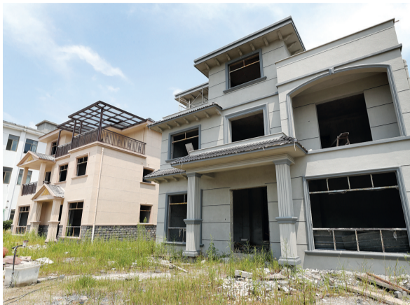
用EPS模块建造的房屋
