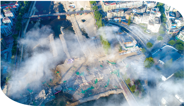
2020年8月15日,原芹江大桥被爆破拆除。 余志明 摄
