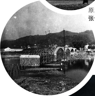
原芹江大桥建设中 张伦 摄
