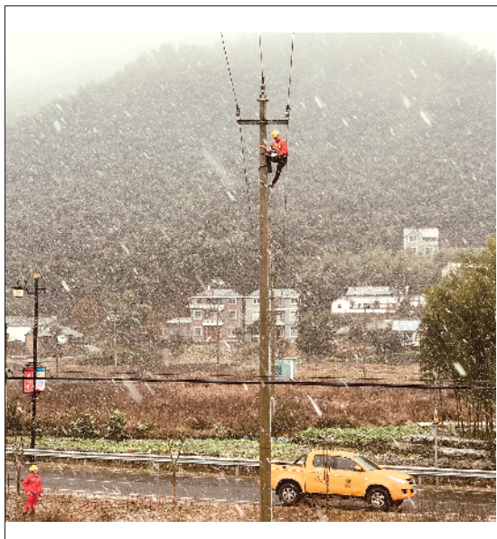
12月14日,受雨雪天气影响,国网龙游县供电公司积极组织红船共产党员服务队开展巡线抢修工作,努力保障第一时间恢复供电。图为抢修人员在溪口镇陈村冒着大雪开展接地线、登杆等一系列操作。 通讯员 方婵媛 张文祺 文/摄
