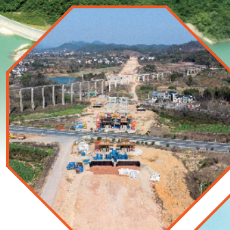
351国道施工现场
