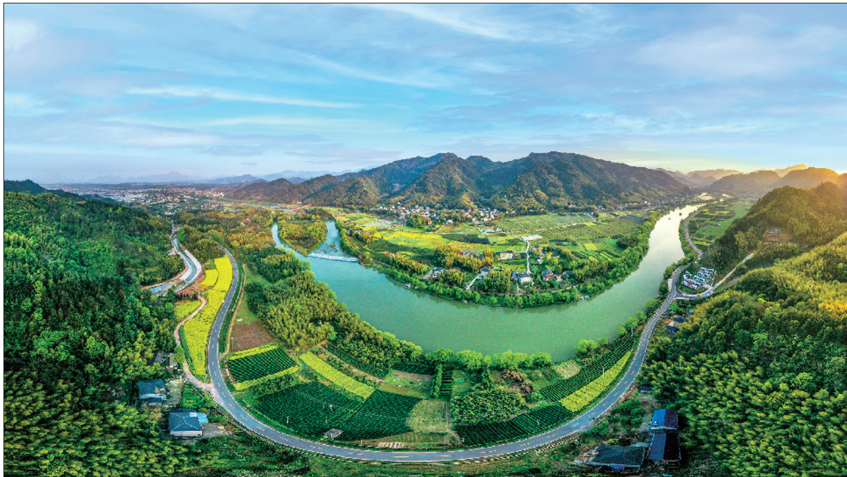
近日,浙江电视台新闻频道《了不起的家乡》第 236 期节目摄影组走进我县灵山江沿江公路,探索最美农村路。该路全长 24.162 公里,全线傍山依水、阡陌如织,通过引景、借景等方式,打造了公路通景、巡防护景、绿道串景的共享共用之路,带来了“车在林中行,路在绿中隐,人在景中游”的美好驾乘体验,实现了公路建设与生态自然的完美融合。
