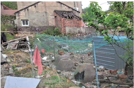
六横镇礁潭村(西厂) 屋前屋后杂物乱堆放
