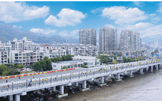
滨港路西段沿海高架
