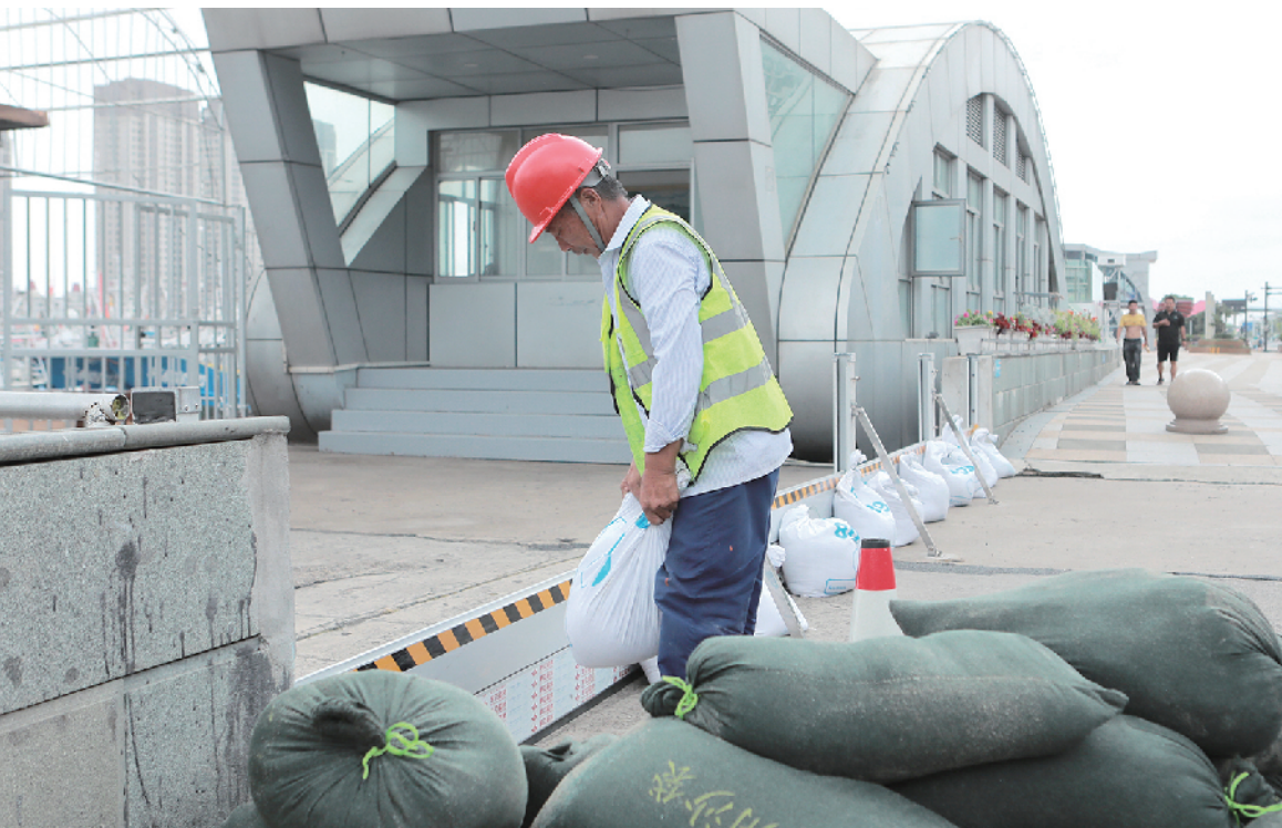
沈家门滨港路沿线防台沙袋加固现场。 记者 罗沛文 摄
