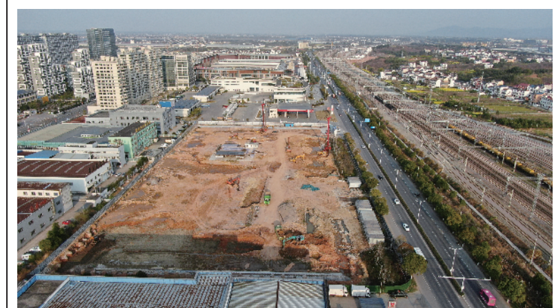
衢江区科教产业园(一期)项目忙施工
