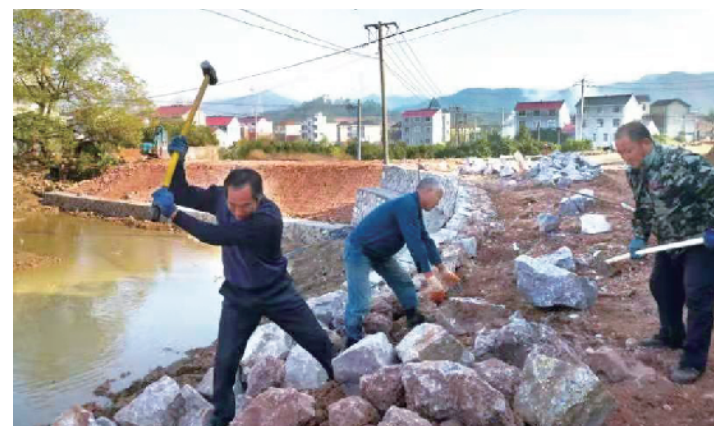
眼下正是冬季少雨季节,后溪镇青塘村的村民们抓住有利天气,对村里的一个小型水库进行浆砌加固,并加宽水库坝,利于车子出行。 姜胜铁/摄
