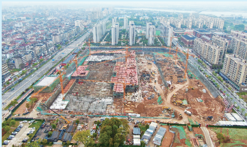
衢州银泰城项目建设现场 邵秀清 / 摄
