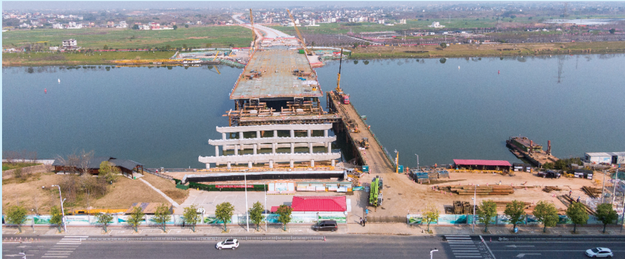
霞飞大桥项目建设现场 郑利文 / 摄
