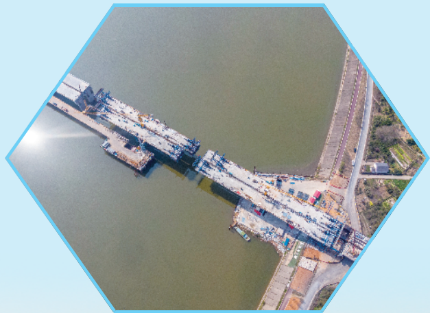
高家快速公路连接线项目建设现场 郑利文 / 摄
