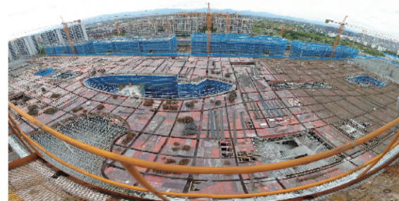
衢州银泰城项目现场
