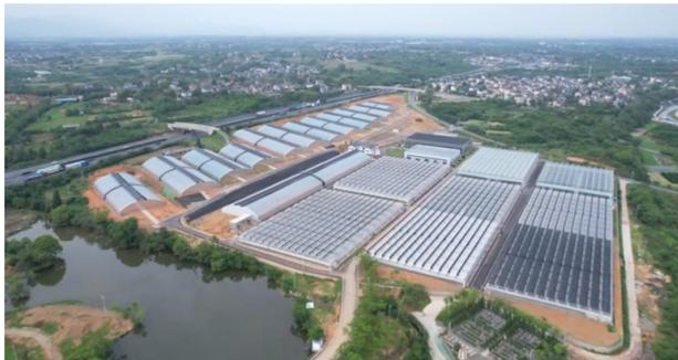
气等功能，能够散除环境中的湿气和水分，减少病虫害。提包式棉被拱棚的内外电动遮阳系统、内部保温幕布系统、风机水帘通风降温系统等科技设备，更适合种植各类蔬菜作物生长。“增加‘棉被’厚度可以很好地达到保温的效果。采用阳光板可以增加光照的时间。二期大棚增加了通风入口，可以保证大棚内空气流通。”傅甸说。
