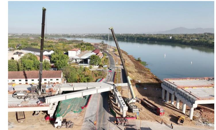
本报讯 (记者 叶晓轩 王昕汉) 12月1日,衢江区新建高安大桥迎来关键性节点,随着最后一块长30米、重80吨的预制梁板落位至预定桥墩,大桥全桥208片梁板安装工作圆满完成,标志着该项目建设迈出关键一步。
