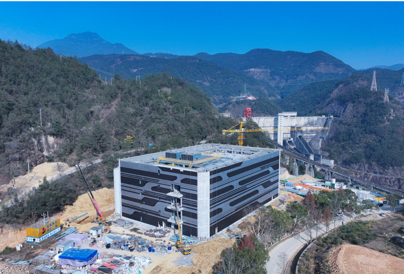
近日,紧水滩水冷式绿色数据中心项目主体工程建设进入立面装修收尾阶段,预计今年3月完工建设。建成后,将成为浙江电力首个大型集约化、创新型绿色低碳的高等级数据中心。
