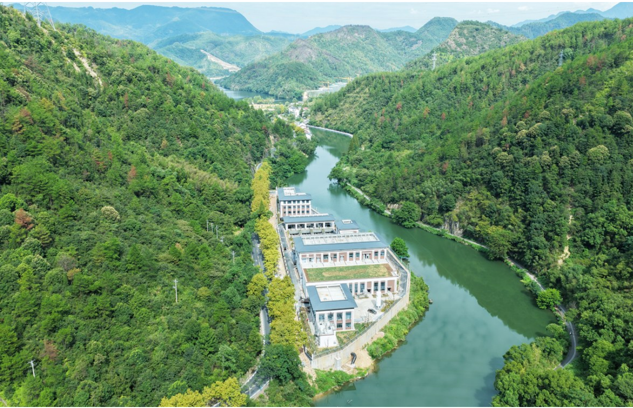
近日,县第二污水处理厂项目已完成工程建设,预计明年投入使用。
