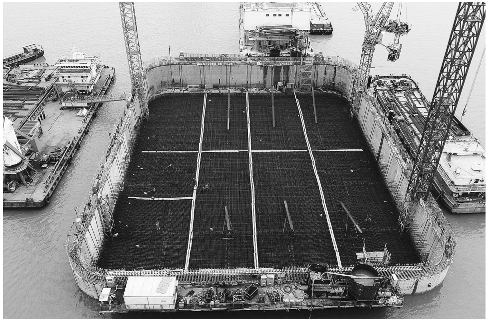
瓯江北口大桥主桥中塔承台施工现场。尤超常/摄
