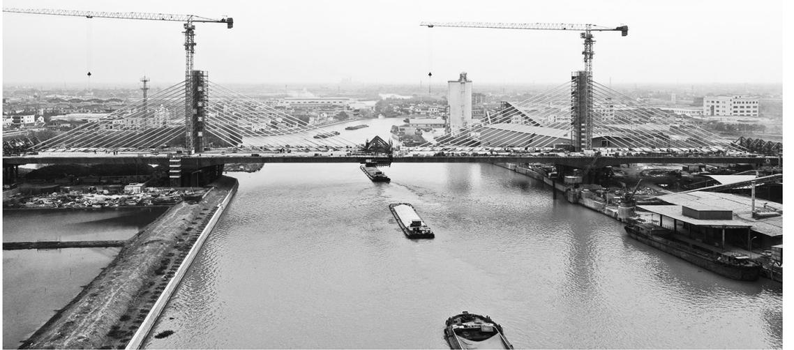
日前,在浙江交通集团负责建设的杭州绕城西复线湖州段京杭运河桥27号墩边跨合龙处,随着最后一方混凝土的注入,京杭运河桥主桥最后一个边跨顺利实现合龙,标志着大桥施工进入最后冲刺阶段。
