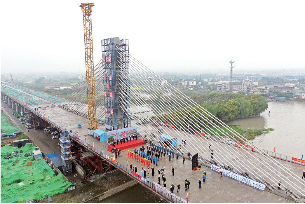
杭州绕城西复线主线贯通现场。蔡俊/摄
