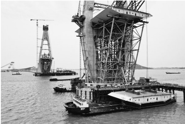
钢箱梁吊装现场。姚峰/摄
