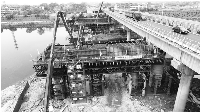
盖梁混凝土浇筑现场。王礼洪/摄
