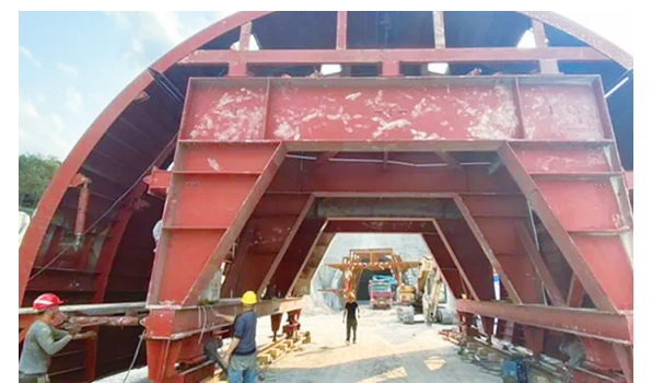
西竹玉公路第一合同段施工现场。徐超颖/摄
