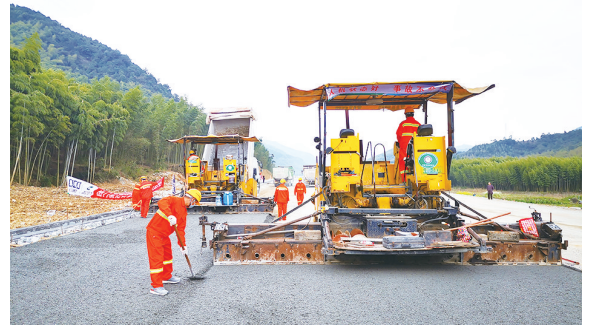
水稳试验段铺现场。吴仕隆/摄
