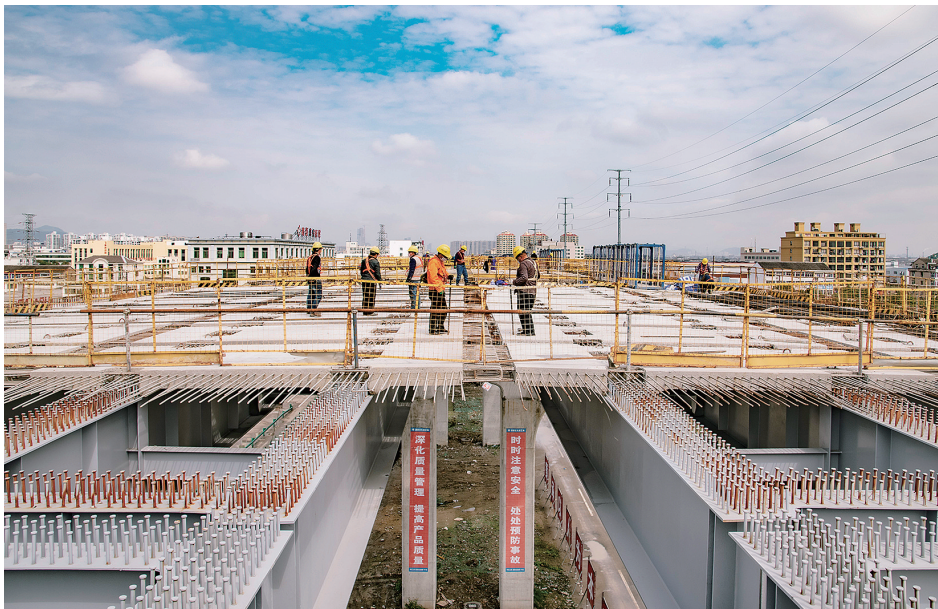
桥面板施工。 林汝秋/摄
