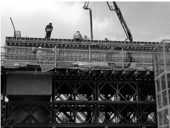
盖梁施工现场。高峰/摄
