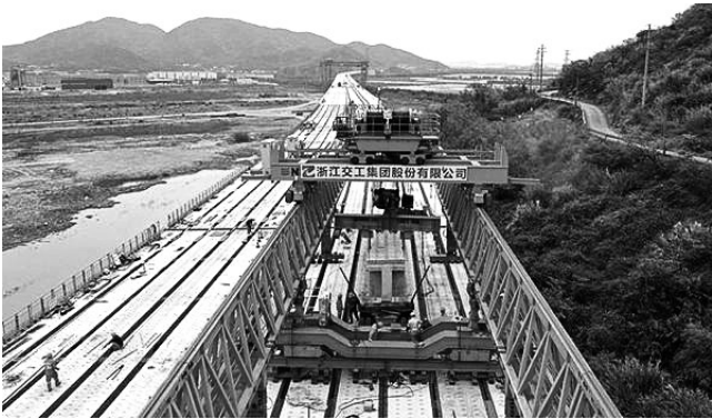
东海农场大桥架梁现场。姚弘/摄
