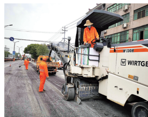
路面“白改黑”改造现场。
