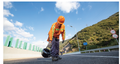
受损路面修补现场。
