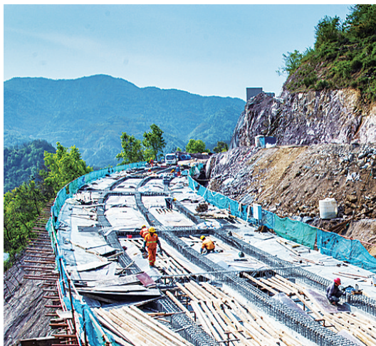
杭绍台高速公路磐安段施工现场。胡肖飞/摄
