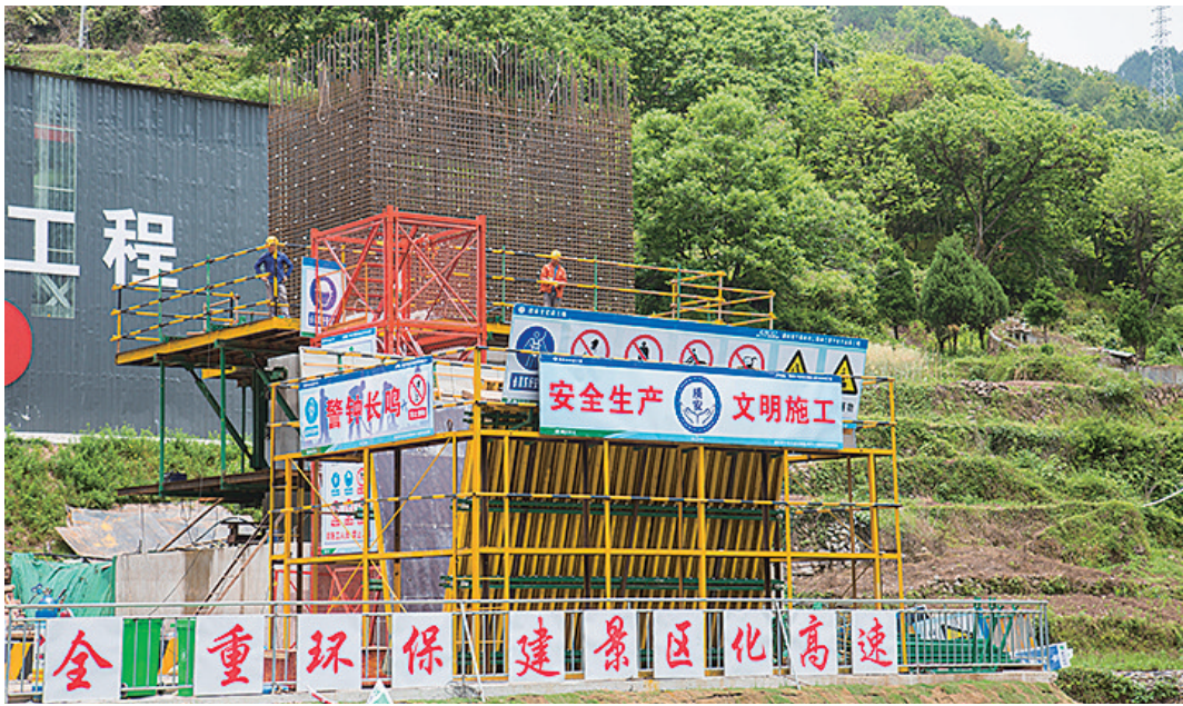
景文高速6标施工现场。孔凡俊男/摄
