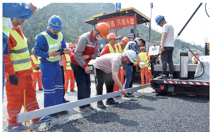
试验段试铺现场。郭安/摄
