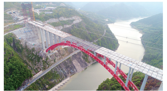
合龙现场。韦凯锋/摄
