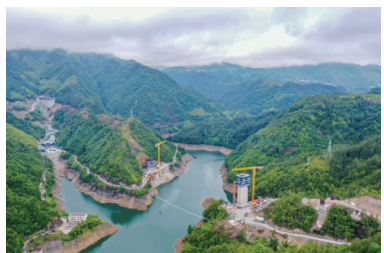
高岭头水库特大桥
