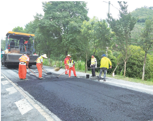
开化 ▲7月29日,开化县公路中心组织养护人员和机械冒着酷暑对G351华埠镇联盟村路段路面病害进行了处治。 □徐曙光 冯劼/摄影报道
