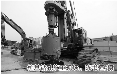
桩基钻孔施工现场。陈书恒/摄
