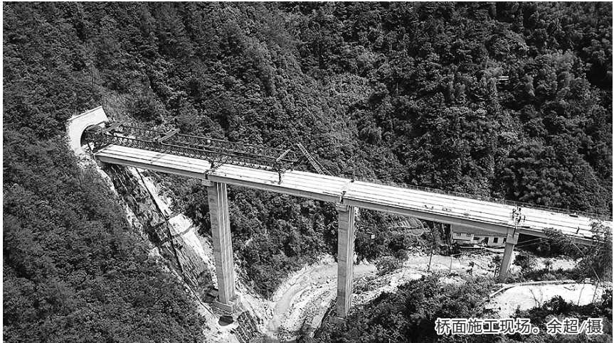
桥面施工现场。余超/摄
