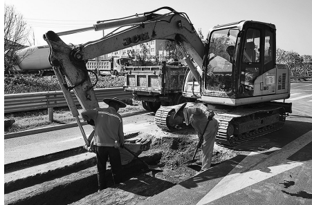
路面修复现场。郑焰升/摄
