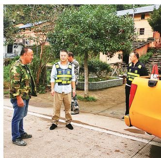
遂昌 ▲近日,遂昌交通运输发展中心和公路养护部门人员共赴528国道龙广线、县道三际线等路段,对在建的公路修复、抢修工地进行安全检查,加强安全管理。 □刘岳峰/摄影报道
