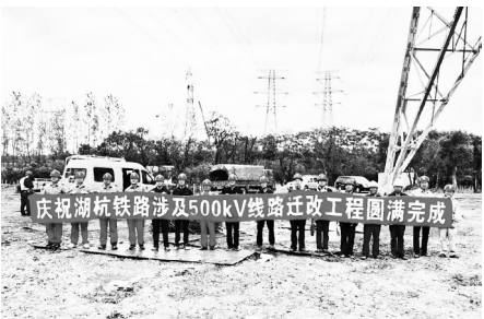
超高压电力线迁改完成现场。章莉莉/摄
