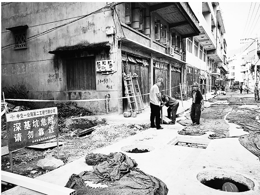
管网改造工程施工现场。陈爱/摄
