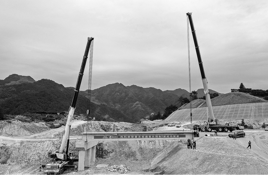
梁板架设现场。梁旭/摄
