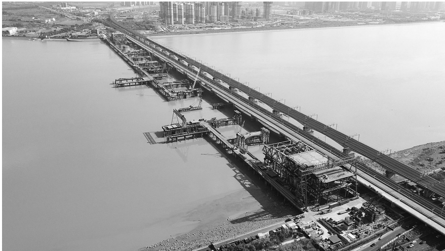
钢桁梁顶推现场。韩潇/摄
