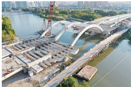
S325复线黄岩马鞍山至后洋段公路工程
