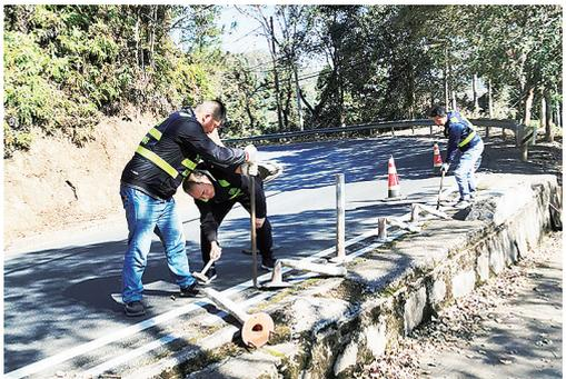
**遂昌** ▲11月6日,遂昌公路养护与应急保障中心安排人员对省道遂龙线K12处的破损警示柱进行了更换,有效保障交通安全。
