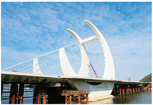
**玉环** ▲近日,玉环市漩门湾“月环桥”施工进入扫尾阶段。图为中交二公局的建设者在吊斗里再度给月牙体喷漆、拆除施工栈桥等扫尾工序,确保大桥在今年年底通车。
