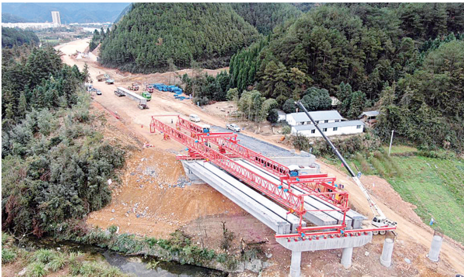
T梁架设现场。熊晓云/摄
