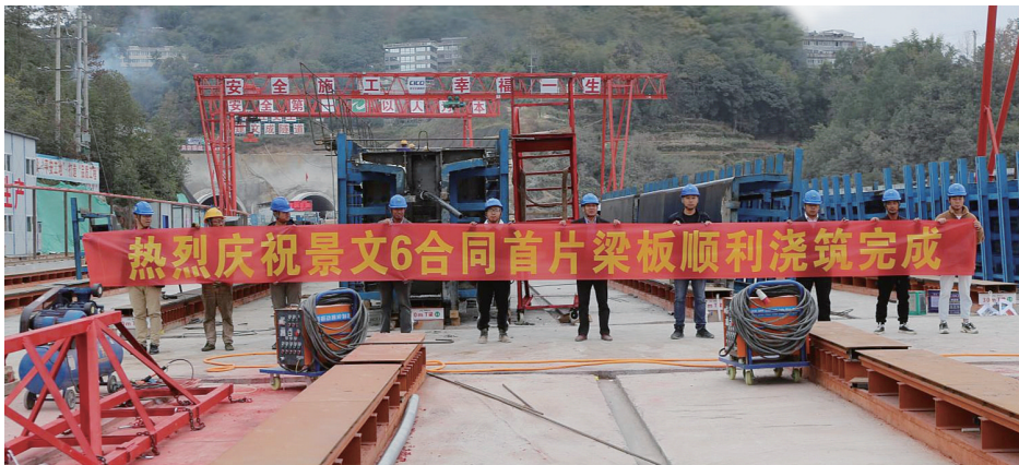
首片预制T梁顺利浇筑现场。唐瑞欣/摄
