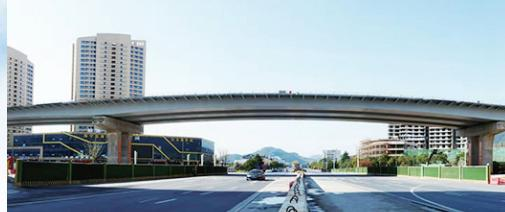
按照施工图纸设计，青溪互通立交桥采用11联现浇箱梁、1联钢箱梁的组成结构。这其中最特殊的钢箱梁就是大桥主体横跨睦州大道的部分。相较于混凝土现浇箱梁，钢箱梁具有质量轻、强度高的特点，适合大跨度的桥梁施工。“使用钢箱梁可以直接跨越睦州大道不需要施工桩基墩柱，满足桥下车辆的顺畅。”千黄6标工程部副部长宋郑军补充道。
