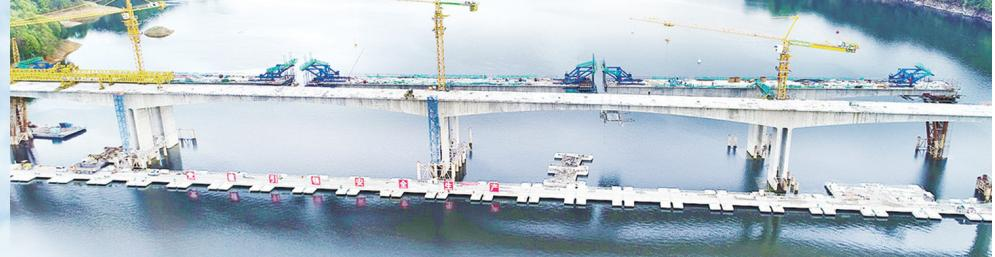
2个月。而在双屏线大桥0#块施工上，千黄1标提前谋划采用预应力反拉系统，代替了传统的沙袋预压方式，提高施工功效，节约了施工工期。通过一系列创新举措，千黄1标在品质工程及标准化建设方面取得了明显的效果。
