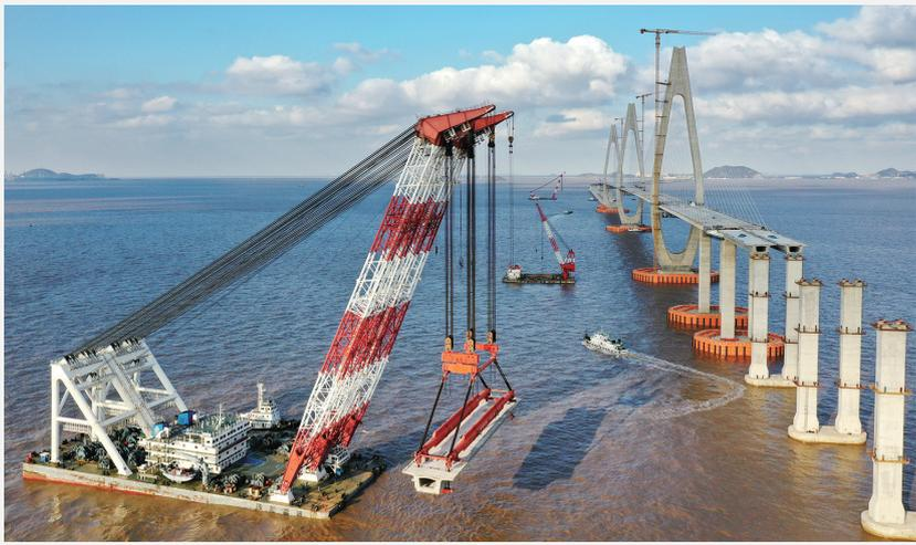
12月20日下午,2600吨起吊功率的“四航奋进”号起重船把一片重达1800多吨的混凝土预制箱梁吊装到舟岱大桥主通航孔桥南边跨高墩身区。
