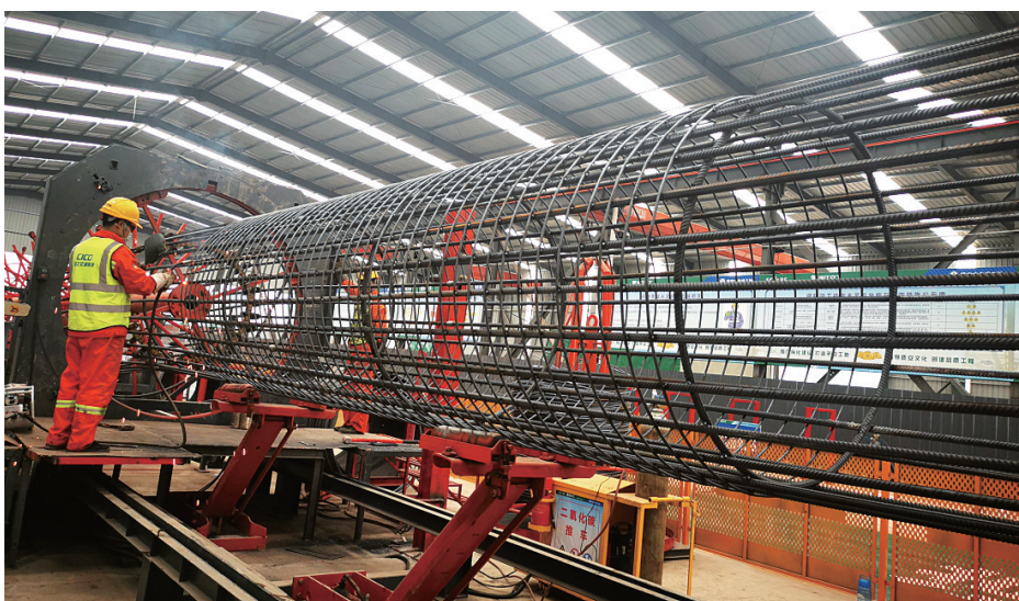
电焊工正在进行桥墩桩基钢筋笼制作。
