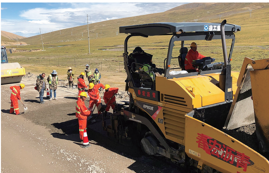
施工现场。土旦格桑/摄
