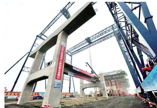
安装现场。韩潇/摄
