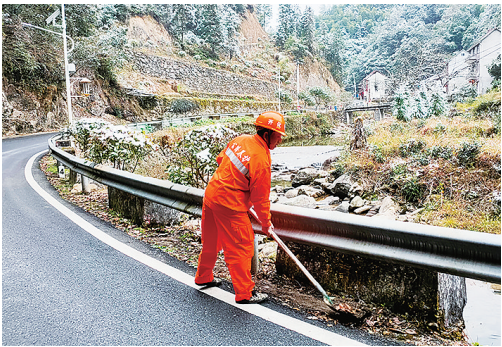
开化 ▲近段时间,开化公路部门组织人员加大对公路边沟、涵洞的及时清理和疏通,确保排水顺畅。图为开化县池淮公路站的养护人员对里河线河滩路段进行水沟清理。 □徐曙光 余坚/摄影报道
