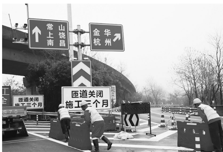
施工人员清离交通管制物品。刘峥/摄
