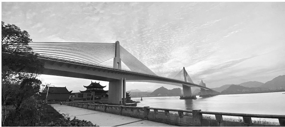
瓯江特大桥一景。叶达峰/摄
