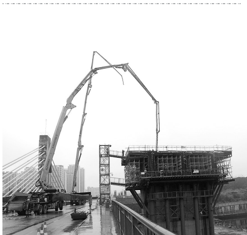
东阳江大桥首个0号块浇筑现场。韦凯锋/摄
