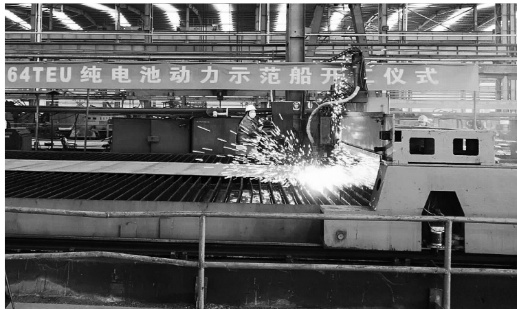
集装箱船建造现场。施梁/摄
