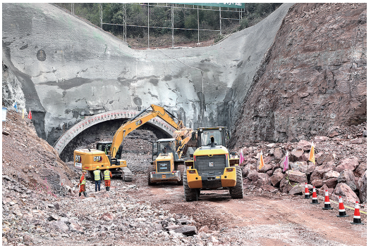
隧道施工现场。
