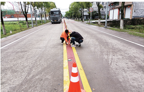
遂昌 ▲日前,遂昌公路应急抢险与保障中心在528国道大柘路段巡查时,发现公路中间多处警示桩损坏,抢险人员迅速对损坏的警示桩进行了修复。 □刘岳峰 金荣法/摄影报道
