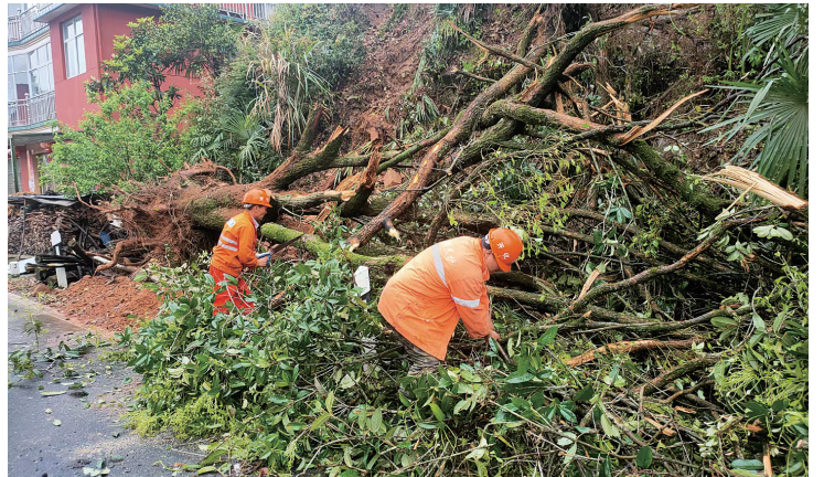
开化 ▲近日,开化县县境内油古线、塘荆线等多条县乡公路出现零星山体塌方。该县公路港航与运输管理中心及时派出养护人员冒雨上路巡查,排除各类险情,消除安全隐患。 □徐曙光余坚/摄影报道
