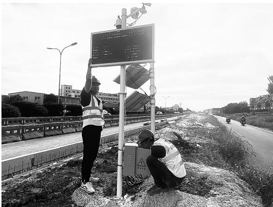
工作人员在安装调试“智慧杆”
