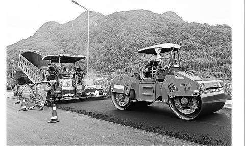
**浦江** 近日，在浦江县S210桐义线虞宅乡新光村路段大中修现场，工人们正在抓紧铺设沥青路面。浦江县普通国道公路养护大中修工程总投资2142万元，目前已完成形象进度50%。
