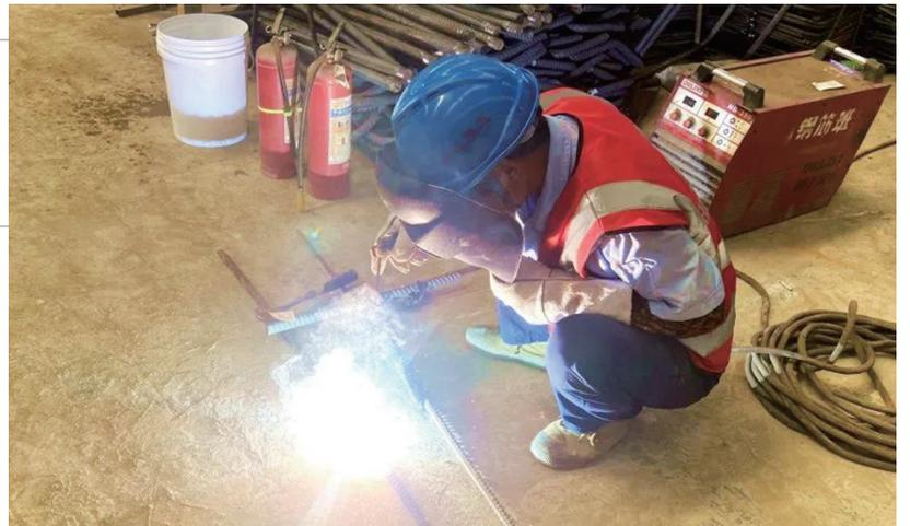
来到“下穿”这个项目以后，黄崇良立即投入“战斗”，不仅承担起重要工序的焊接工作，还作为老师傅将经验和技能传授给十几名焊接工人。“比如底板、顶板的支撑筋，如果焊不结实，容易发生塌陷，对中间施工的工人造成威胁，像这种关键部位，都是由黄师傅带着技术人才做的。”卢赵伟介绍，自从黄崇良来到项目上，焊接工作有了极大改观，监理现场取样的合格率达100%。
