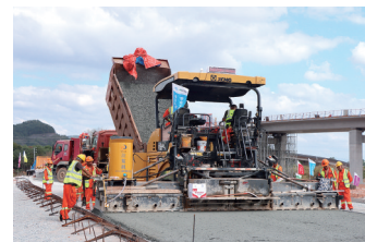
施工现场。唐艳宁/摄
